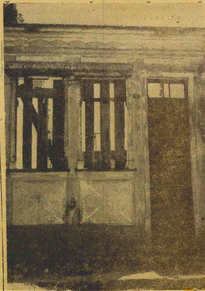
Casa demolida pelo governo, à rua Bulcão Viana
