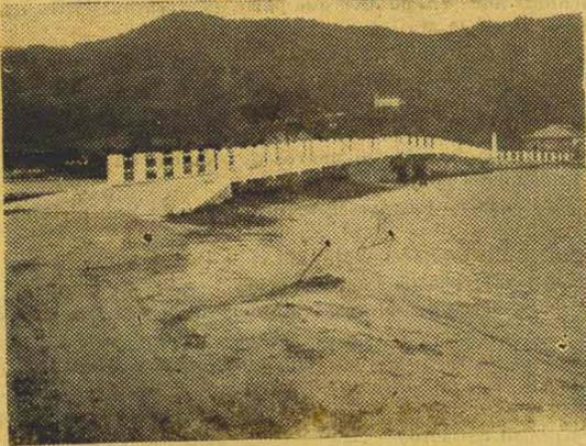
A ponte da Lagôa da Conceição, toda de cimento armado, com 100 metros de comprimento, pronta já há um ano.
