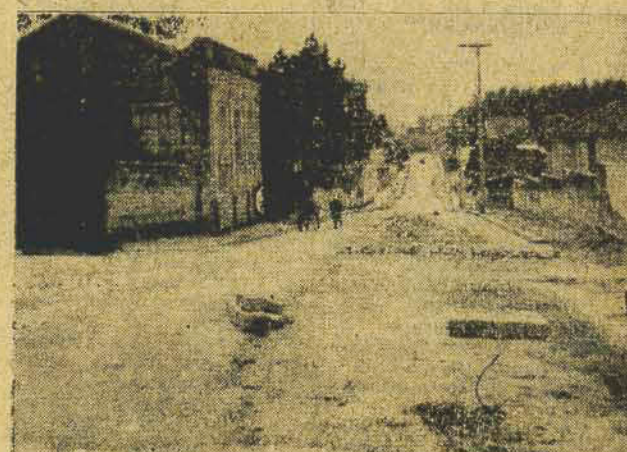
Terminação do calçamento da Rua Presidente Coutinho, vindo-se a parte da rua transversal que vai sair na Praça "Getúlio Vargas"
