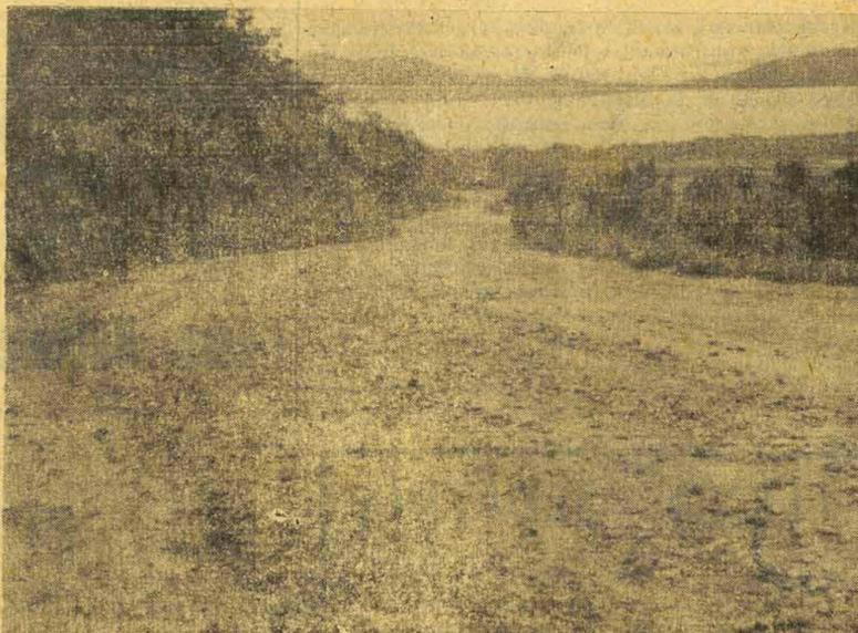
A ex-famosa Estrada da Lagoa, com o perigoso Morro das Sete Voltas, que só oferecia tráfego em dias de sol construída, com as curvas alargadas e toda macadamizada, oferece a vantagem de ir-se a Lagoa com qualquer tempo e em qualquer veículo
