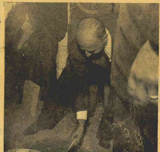
O banqueiro, sr. Genésio de Miranda Lins, quando assentava a pedra fundamental da Fábrica de Cimento Portland.
