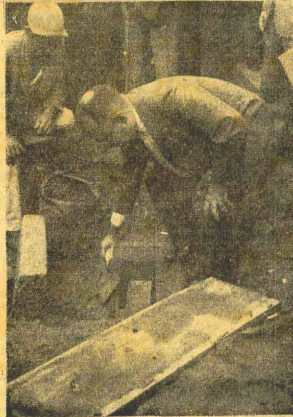
O dr. La Roque depositando a primeira pá de cimento, ato esse que marca o início do edifício com 10 pavimentos para os Comerciantes
