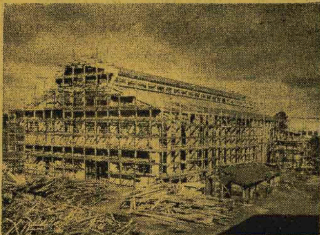
Em cima, vista geral do pavilhão principal da Fábrica de Antibióticos da Rhodia, em Santo André, Estado de São Paulo
