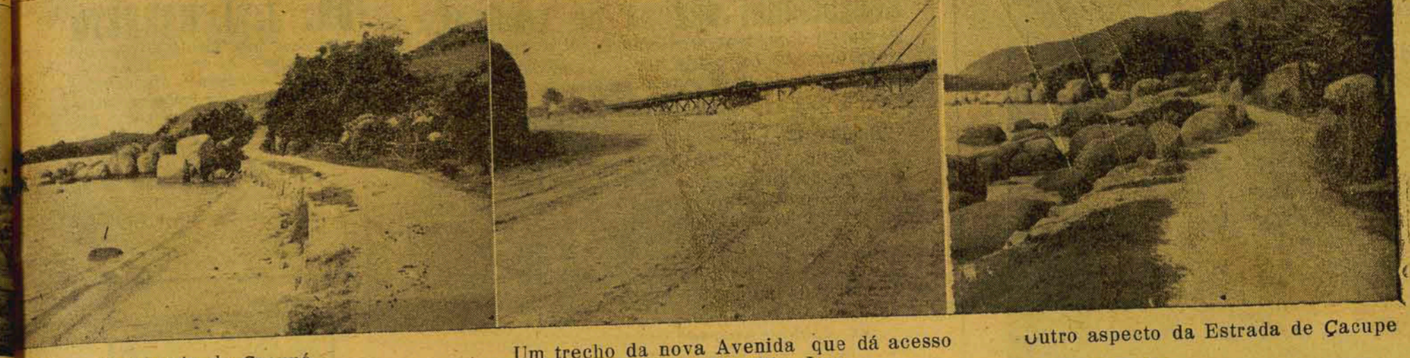
A no va estrada de Cacupé
