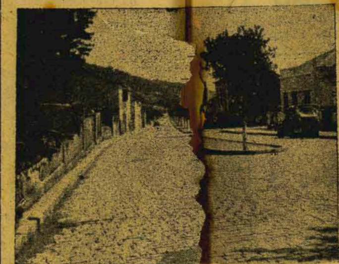
Trecho do calçamento da Rua Mauro Ramos
