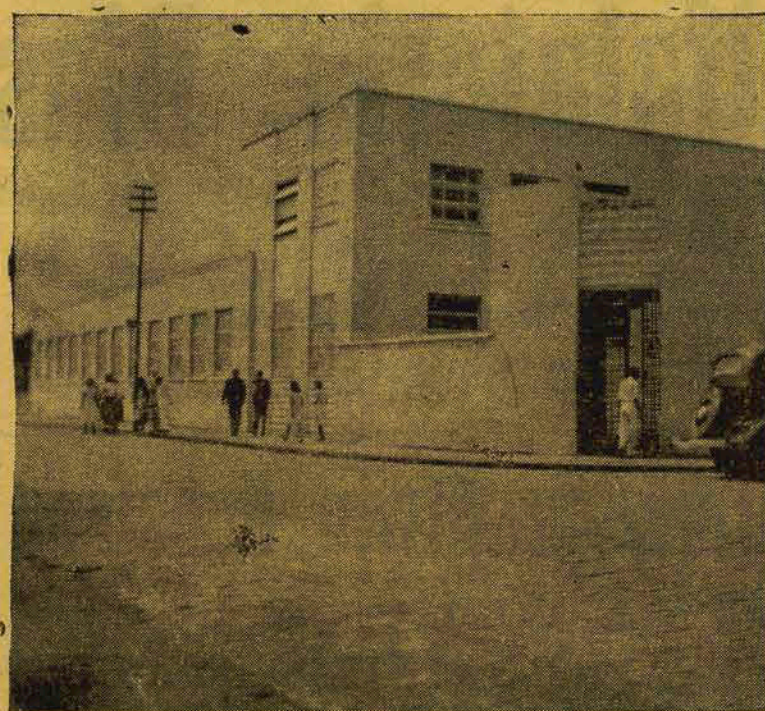
Edifício das oficinas do D. E. R., no Estreito, onde são reparados todos os veículos e máquinas daquele Departamento.
