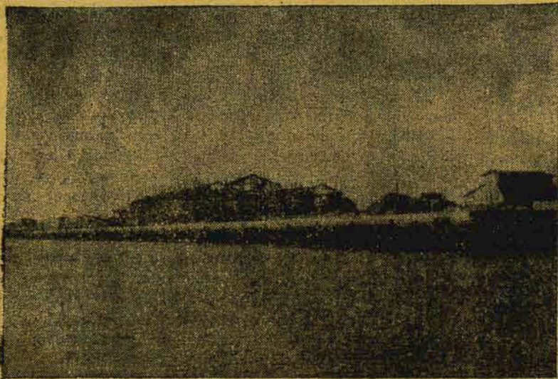
233 m.l. de cais acostável em c.a., unico existente, veñdo-se ao fundo a silhueta da 1ª metade de um armazem com 2.000 m2. de área útil, na sua fase de construção em abril de 1948
