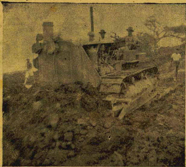
Possante máquina preparando o terreno, também no trecho que acima nos referimos.
