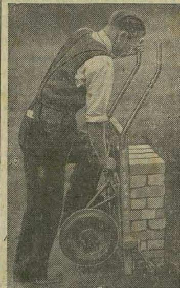
CIENCIA APLICADA — O Ministério das Obras Públicas da Inglaterra está incentivando o desenvolvimento de novos métodos de construção de casas. Vemos na fotografia um novo tipo de carrinho que mediante o funcionamento de uma alavanca, pode carregar automaticamente 40 tijolos — BRITISH NEWS SERVICE
