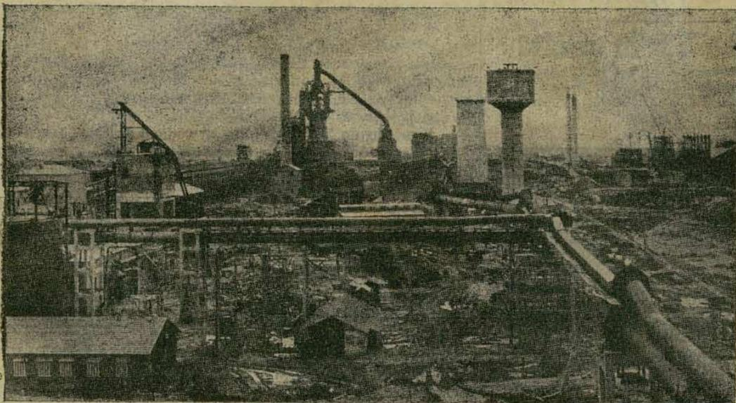
VISTA PARCIAL DA USINA. — Nesta vista parcial da Usina vemos ao centro a estrutura do alto-forno, à esquerda o viaduto de minérios e à direita a estrutura metálica do edifício dos fornos da aciara, em construção.
