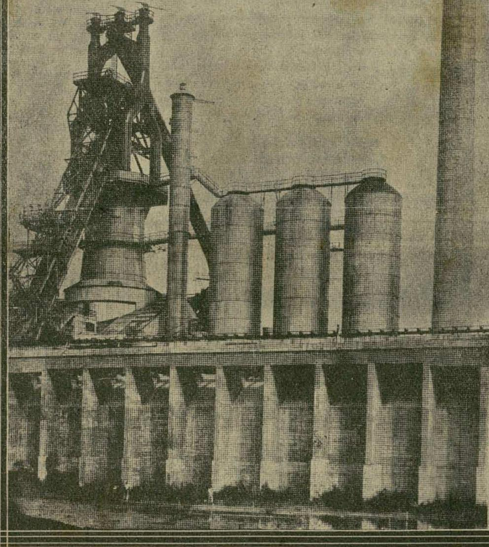
VOLTA REDONDA — O primeiro alto-forno da usina de Volta Redonda, vendo-se a chaminé, os regeneradores de gás, o alto forno propriamente dito e parte da estrutura metálica da Casa de Corrida. Aparece também, entre o alto-forno e os regeneradores, o elevador de passageiros. (Vide reportagem às páginas 4, 5, 6 7)
