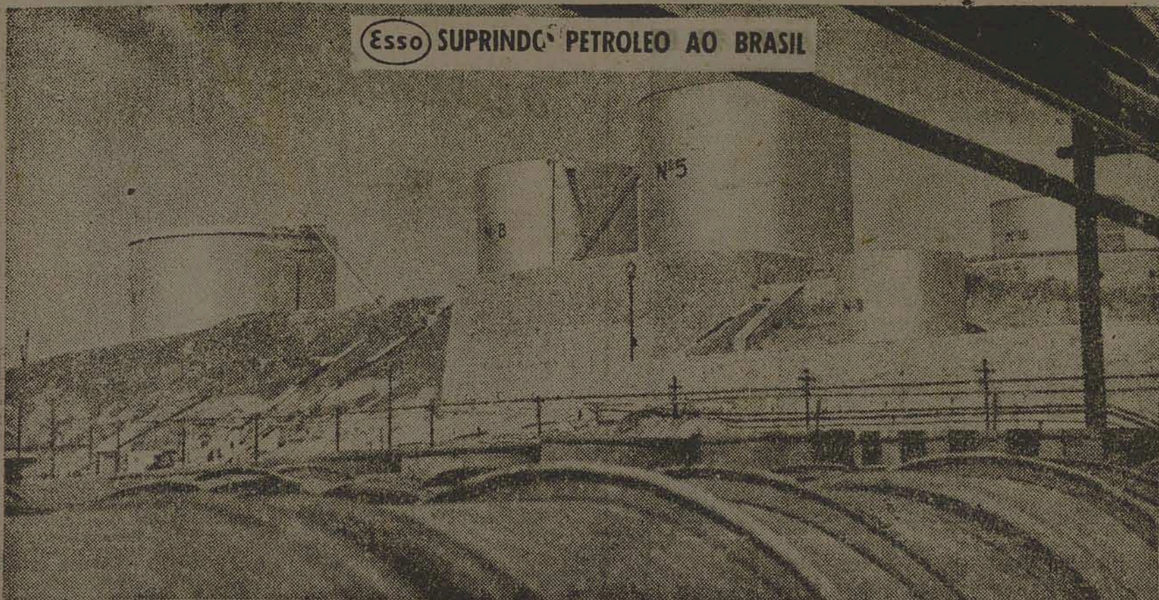
Visão de parte de uma das nossas atuais instalações no Brasil.
