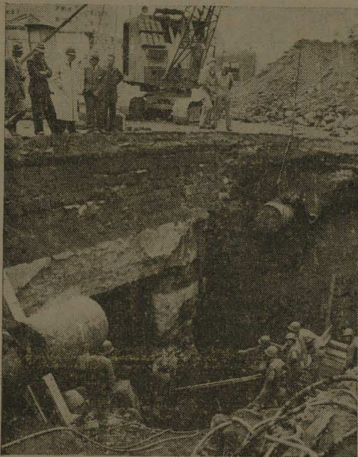
A RECONSTRUÇÃO DE NAPOLES - Engenheiros dos Estados Unidos reconstruem apressadamente as instalações de água e gás em Nápoles, destruídas pelas minas instaladas pelos nazistas. A destruição, pelos nazistas em retirada, dos serviços públicos causou grandes transtornos à população da grande cidade, porém os reparos feitos com brevidade evitaram o perigo das epidemias. (Foto da Inter-Americana para O ESTADO).
