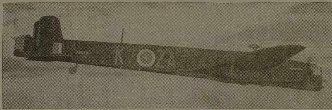
Os bombardeiros "Whitley" da RAF — um dos quais a gravura nos mostra no momento da partida para mais um dos seus vôos a longa distância — tem uma velocidade que gira em torno de 395 quilômetros horários, um raio de ação de cerca de 1.800 milhas e um tecto de serviço de 23.000 metros. Dotado de dois motores Rolls Royce "Merlin", o formidável armamento de que dispõe inclui 1 torre dianteira e 4 torres traseiras de metralhadoras, todas operadas por meio de electricidade.
