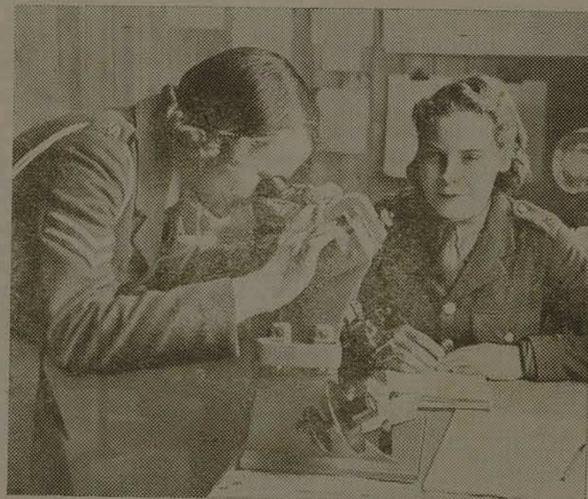
Inimaginável é o trabalho das moças do Serviço Auxiliar Terrestre Britânico, no auxílio para aumentar o êxito das metralhadoras anti-aéreas. Com um instrumento especial, estudam o recorde de explosão das balas, por meio de fotografias. Esse filme é passado na máquina, que se vê na fotografia, e mostra os ângulos e as alturas dos tiros, permitindo assim um estudo para o aperfeiçoamento dos mesmos. (Foto de “British News Service”, para O ESTADO)
