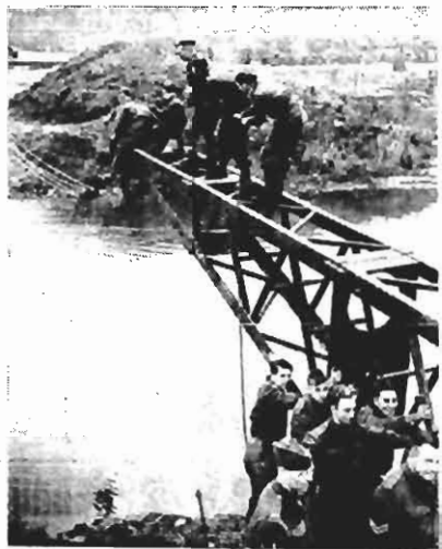
Construção de pontes constitui uma grande parte do trabalho dos Engenheiros Reais da Grã-Bretanha que são vistos aqui treinando recrutas na construção de um ponte sobre um rio. (Fóto de British News Service, para O ESTADO).
