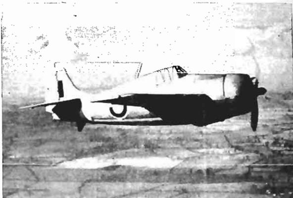
A Fotografia mostra um Grumman "Martlet I" em patrulha. O Grumman "Martlet I" é caza de um único lugar, que possui duas metralhadoras na fuselagem, e duas em cada asa. Esse aparelho acha-se agora a serviço da Aviação Naval da Grã Bretanha. (Foto especial de "British News" para O ESTADO).
