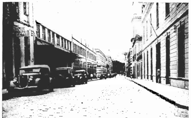
Bellíssima perspectiva da rua Felipe Schmidt — hoje a mais importante artéria da capital e cujas obras de alargamento e prolongamento o sr. prefeito Mauro Ramos está continuando com ativa e elogiável inteligência
