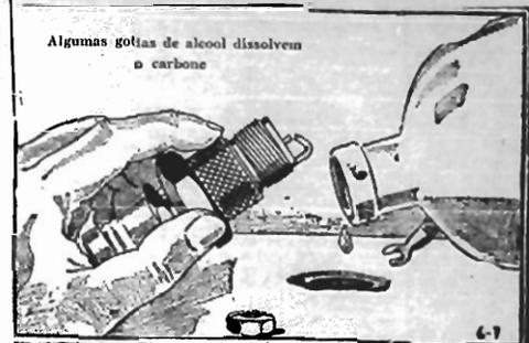
ALCOOL PARA O CARBONE — O alcool pôde ser usado para remover o carbone. Não é precisamente um dissolvente do carbone, mas elimina os elementos adherentes que ligam as particulas de carbone. O alcool solta o carbone por tal forma que a maior parte desaparece pelo tubo de descarga. Quando o
