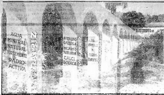
Aquoducto construido pela Empresa para o transporte da agua mineral, sem contacto com o subsolo, entre a Fonte e o Pavilhão de Engarrafamento.
