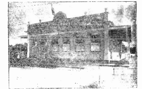
Vista principal do novo edificio das Escolas Reunidas.
