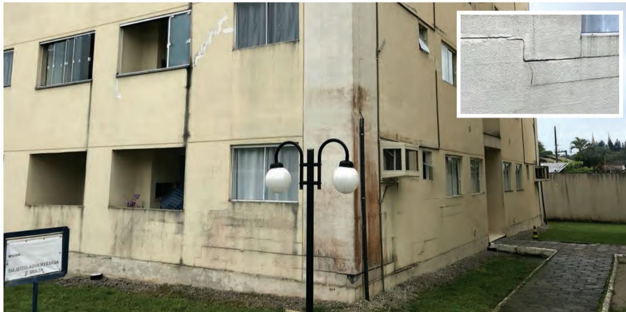
RECALQUE no solo e na estrutura do prédio resultaram em rachaduras, que comprometeram a estrutura do bloco
