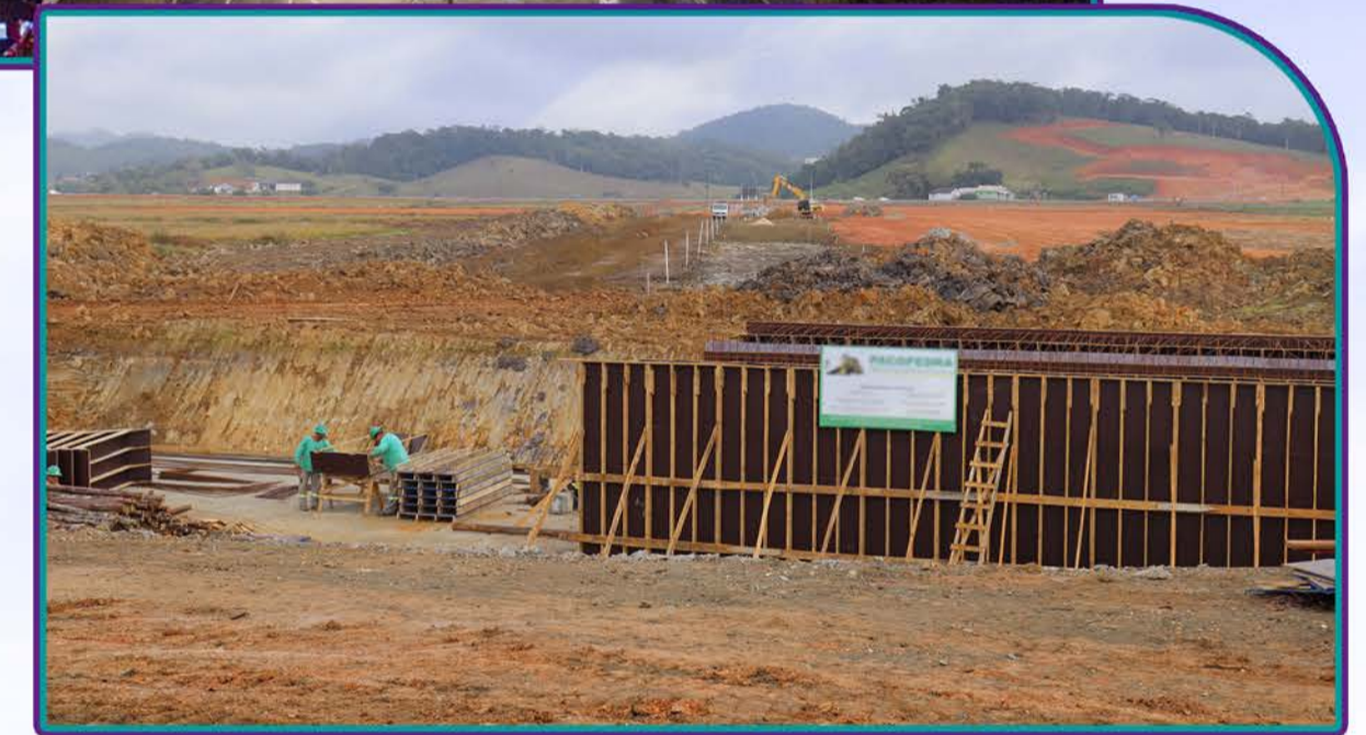
Anel de Contorno Viário Urbano (em andamento)
