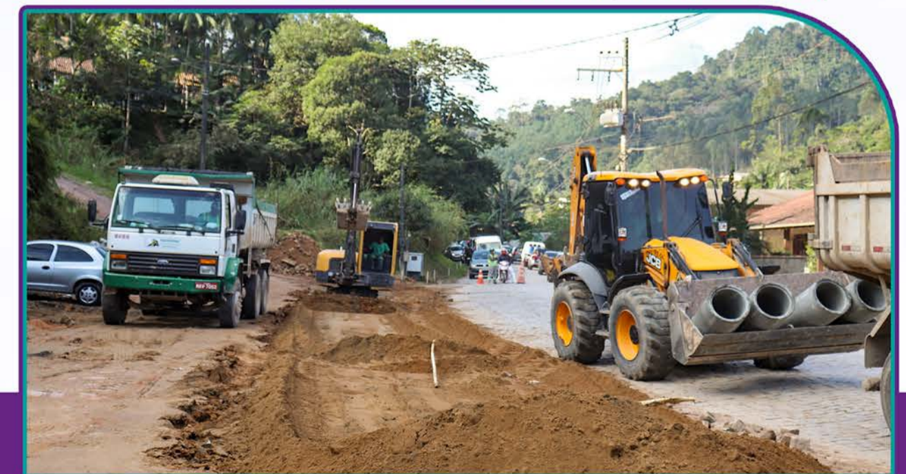
Reurbanização da Rua Bonifácio Haendchen (em andamento)
