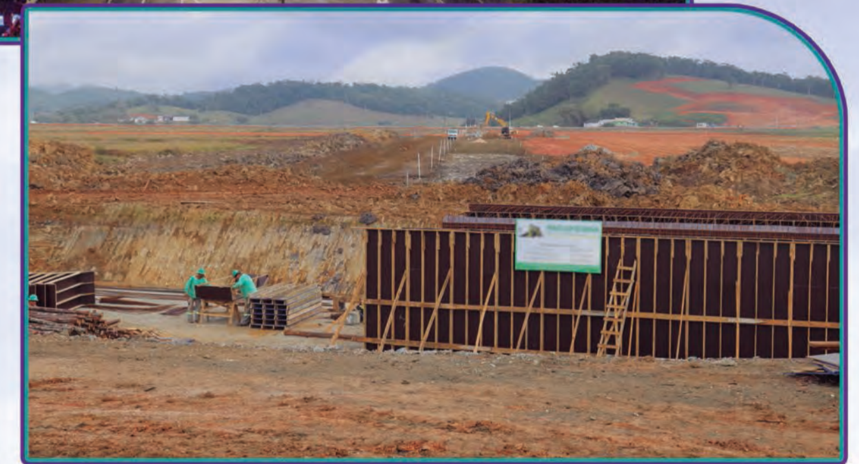
Anel de Contorno Viário Urbano (em andamento)
