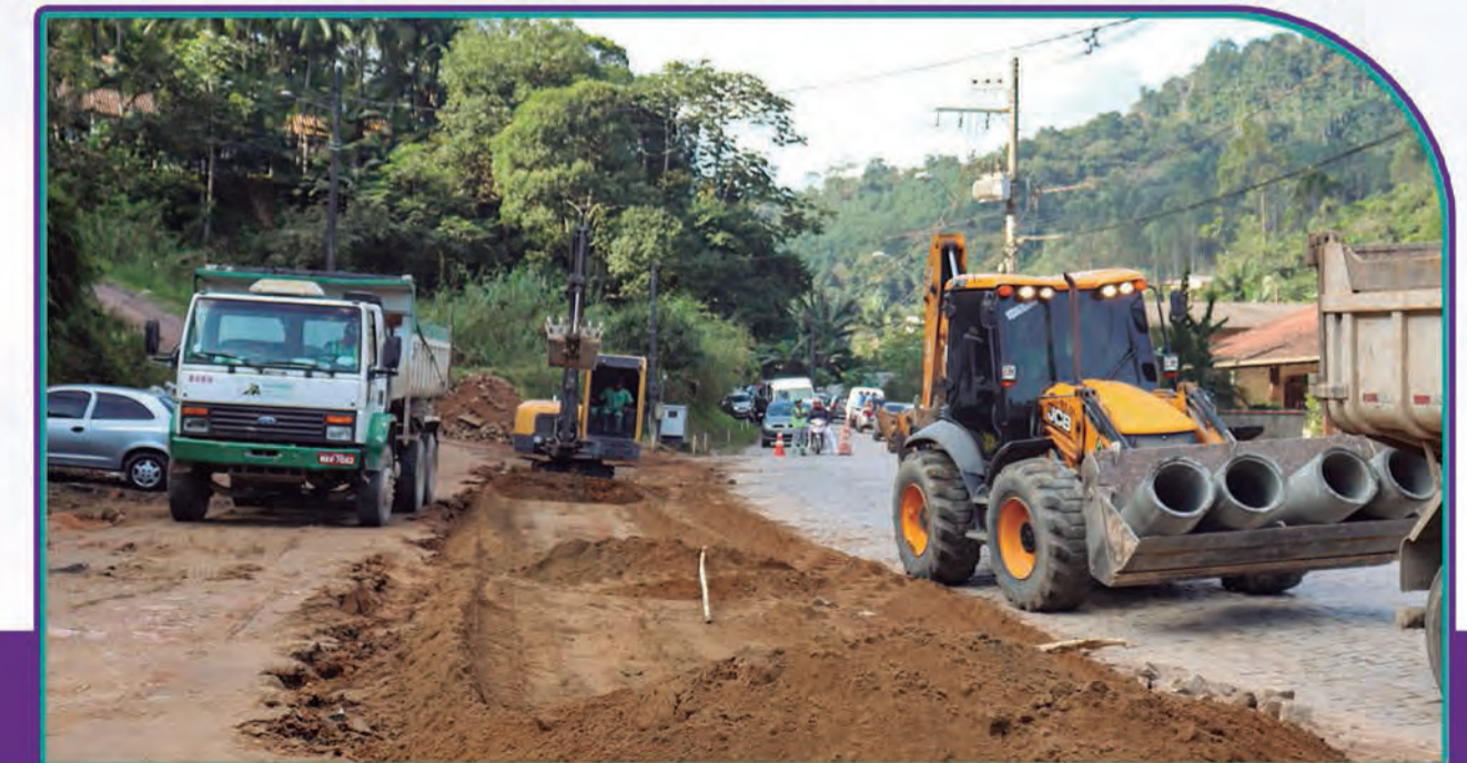
Reurbanização da Rua Bonifácio Haendchen (em andamento)
