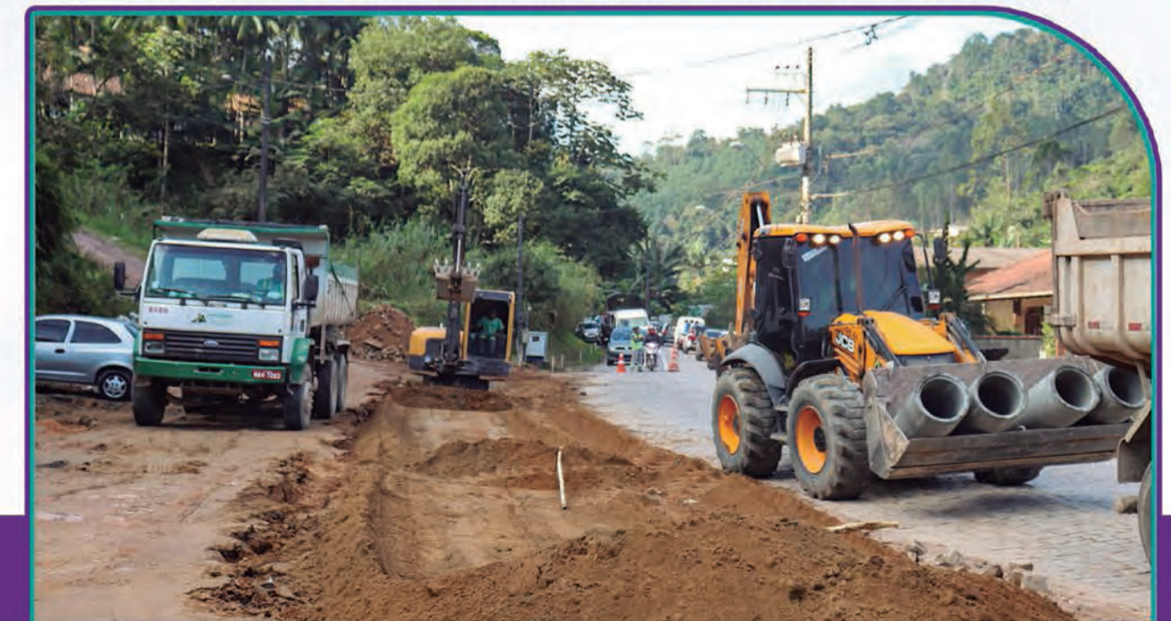
Reurbanização da Rua Bonifácio Haendchen (em andamento)
