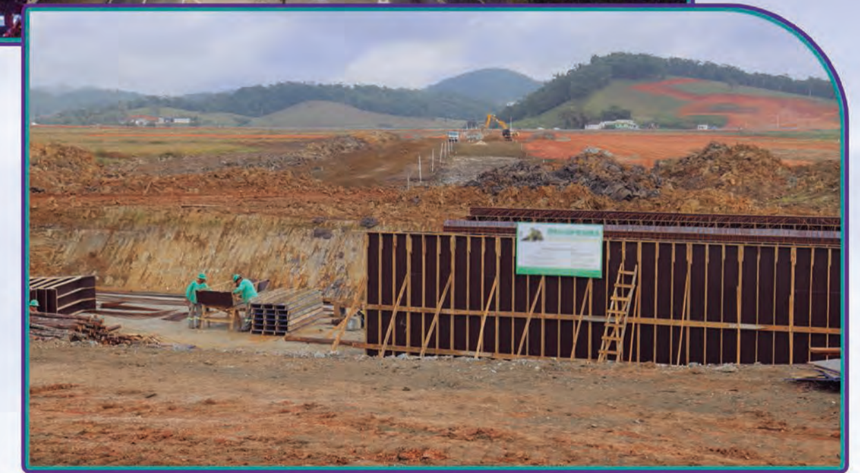
Anel de Contorno Viário Urbano (em andamento)
