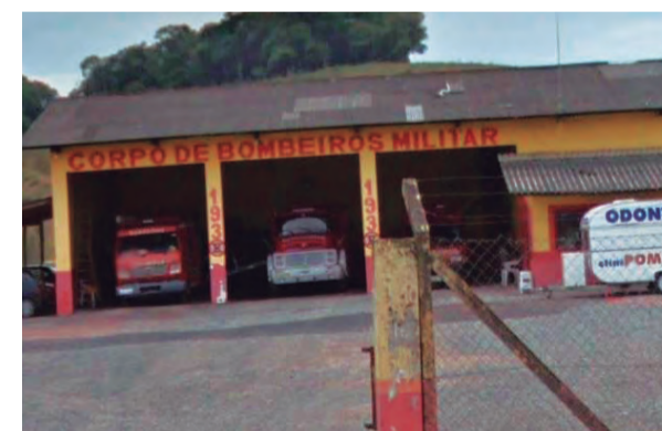
Estrutura na Av. Deputado Francisco Mastella
