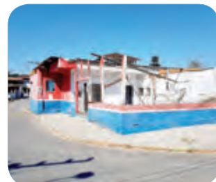
Ref. 1635 TR c/ 180m 2 e casa c/ 70m 2 , quarto, sala, cozinha, banheiro, área de serviço R$160.000,00 - Centro
