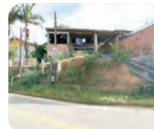
Ref. 1647 Casa c/ 293,75m 2 , 1 sala, 3 quartos, 1 banheiro, cozinha, área de serviço e 3 vagas de garagem R$140.000,00 - Gasparinho
