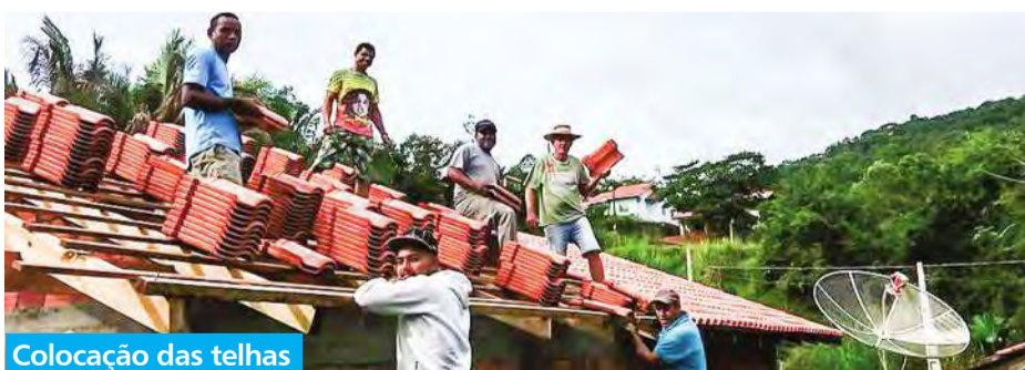
Cobertura de casa
