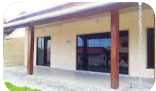
REF. 958 Casa 01 suite, 02 dormitórios, 02 bwc, sala de visita, sala de tv, cozinha, área de serviço, churrasqueira, 03 vaga de garagem, portão eletrônico. C/ 235 m² Bairro 7 setembro R$ 420 Mil
