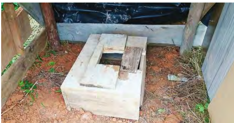
BANHEIRO da casa foi construído do lado de fora da residência
