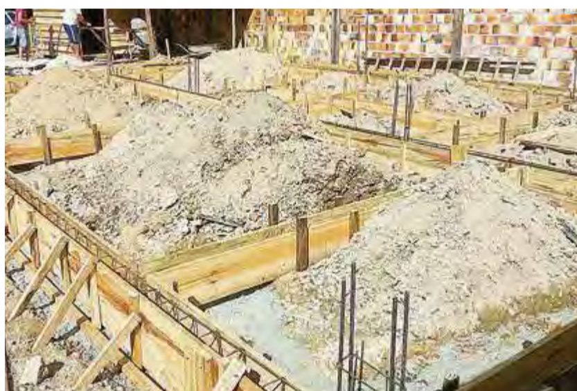
PEDREIROS já estão trabalhando no fundamento da nova casa
