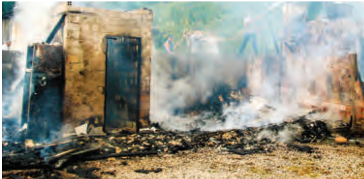
CASA da família de Vavá foi totalmente destruída por um incêndio no dia 13 de março
