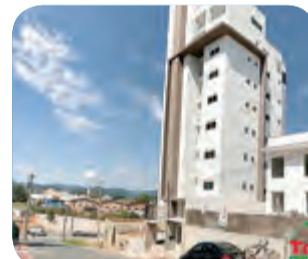
Ref. 1594 Apto c/ 353,22m 2 , 2 salas (social e jantar), 3 suítes, cozinha, lavabo, copa, sacada, área de serviço, área de festas, piscina aquecida, 2 elevadores, murada, portão eletrônico, interfone, jardim, 3 vagas de garagem R$1.400.000,00 - Sete de Setembro
