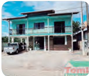
Ref. 1099 TR com 594m 2 e casa com 275m 2 , 2 pisos, 2 salas, 1 dormitório, 2 suítes, 02 banheiros, cozinha, área de festas, churrasqueira, piscina, 2 vagas de garagem R$498.000,00 – Centro
