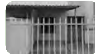
REF. 918 Casa Geminada 02 dormitórios, BWC, sala de visita, sala de tv, cozinha, área de serviço, garagem. Com 72 m 2 Bairro: Santa Terezinha R$ 179 mil.
