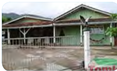
Ref. 250 Casa mista, 02 quartos, 02 banheiros, sala, cozinha, amplo espaço externo, livre de exente, garagem, murada. Ilhotinha. R$140.000,00
