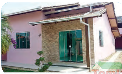
Ref. 265 Casa de alvenaria com 67m 2 , terreno com 310m 2 , 02 quartos, 01 banheiro, sala, cozinha, área de serviço, área de festa, móveis planejados, garagem, portão eletrônico, murada. Centro. R$260.000,00.
