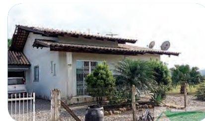
Ref. 266 Casa de alvenaria com 148m 2 , terreno com 760m 2 , 02 quartos, 01 banheiro, sala, cozinha, área de festa com churrasqueira, área de serviço, 01 vaga de garagem coberta. Barranco Alto. R$145.000,00.
