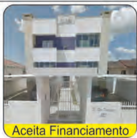
Apto (cod. 0277) Bairro Santa Terezinha 02 dormitórios, sala de estar/jantar, cozinha, lavação, garagem R$ 185.000,00
