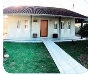
Ref. 1388 Casa de Alvenaria Terreno com 470m 2 e casa 160m 2 , 2 quartos, 1 suíte, banheiro, sala, cozinha, varanda, área de serviço, área de festas, murada, churrasqueira, jardim, 2 vagas de garagem, fica mobília da cozinha R$380.000,00 - Coloninha
