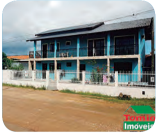
Ref. 1273 TR c/ 479,04m 2 e casa c/ 360m 2 . 2 pisos, 2 salas, 4 dormitórios, 2 suítes, 3 banheiros, 2 cozinhas, 2 salas de jantar, sacada, área de serviço, área de festas, murada, churrasqueira, portão eletrônico, jardim, 04 vagas de garagem R$490.000,00 - Santa Terezinha
