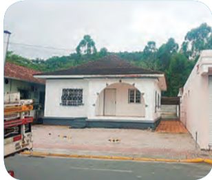
Ref. 1058 Casa de Alvenaria para fins Comerciais: Terreno 500m 2 (Frente 12,20m 2 X 40m 2 Fundos) e casa 300m 2 , 2 salas, 3 quartos, banheiro, cozinha, varanda, área de serviço, murada, R$1.300.000,00 -Centro
