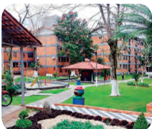
Ref. 1316 Apartamento c/ 50m 2 , sala, cozinha, 1 banheiro, 2 dormitórios, área de serviço, área de festa, portão eletrônico, mobília, interfone, 1 vaga de garagem R$ 120.000,00 – Bela Vista
