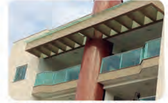
REF. 917 Apto 01 suite, 02 dormitórios, BWC, Sala, varanda, cozinha, área de serviço, garagem, churrasqueira, salão de festas, playground, portão eletrônico com 101,24 m 2 R$ 346.500,00.
