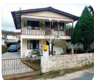
Ref. 1318 Casa Mista TR 270m 3 e Casa c/ 105m 2 , 2 quartos, 2 pisos, 2 salas, 2 banheiros, cozinha, varanda, área de serviço, jardim, 02 vagas de garagem. R$150.000,00 - Gasparinho
