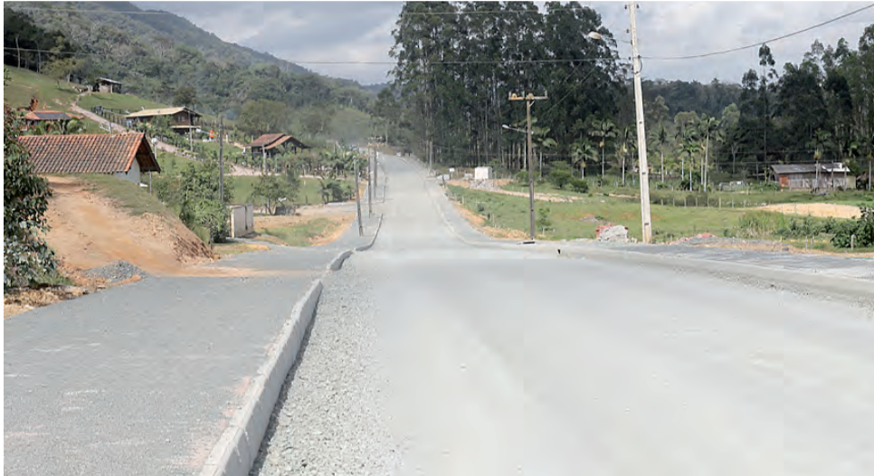
EMPRESA aguarda emissão da nota para voltar ao trabalho de pavimentação
