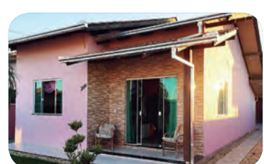
Ref. 194 - Casa no loteamento primavera, 2 dormitórios, sala , cozinha planejada, banheiro social, sala de jantar, garagem coberta e área de festa com banheiro, churrasqueira e fogão a lenha. R$ 240.000,00.
