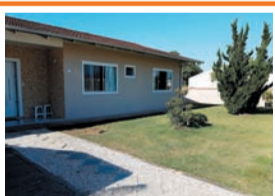
Ref 19 - Casa de Alvenaria em ótima localização, rua sem saída, lugar tranquilo e muito seguro. Endereço: Gaspar - SC Bairro: 07 De Setembro. Aceita imóveis em Gaspar de menor valor e veículos na negociação. Valor R$ 650.000,00
