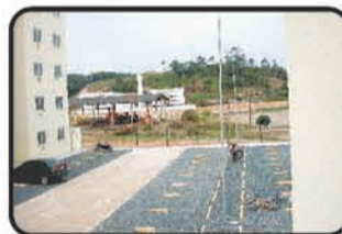
REF.866 - Apto. 02 dormitórios, BWC, cozinha, sacada, 01 vaga de garagem, área de serviço, churrasqueira e elevador. Com 60m 2 . Bairro: Gaspar Grande. R$ 145.000,00
