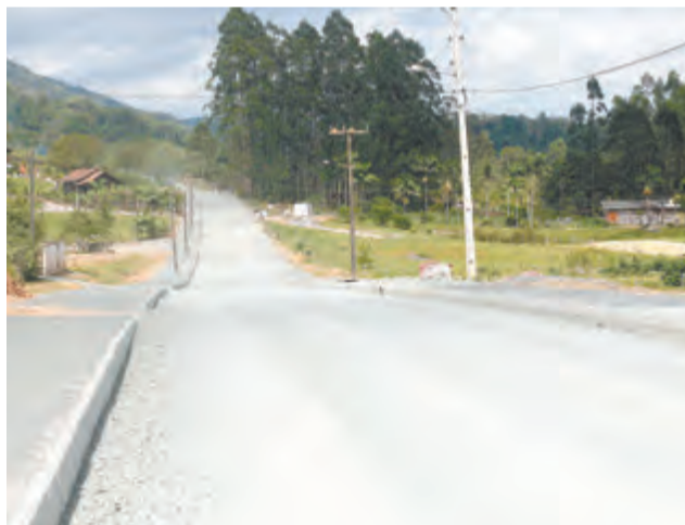
Trecho seguinte está com a calçada concluída e com a pista de rolamento pronta para receber asfalto
