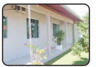
REF. 859 Casa 1 suíte, 1 dormitório, 3 BWC, sala de visita, Tv e jantar, cozinha, área de serviço, despensa, garagem, piscina, portão eletrônico c/ 150 m² R$ 315.000,00
