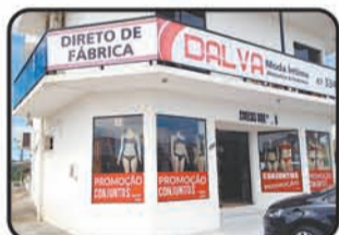
REF. 844 - Casa e Loja - 1 Suite, 2 Dormitórios, 3 BWC, sala de Visitas, Jantar e TV, Varanda, Copa, Cozinha, 3 pisos, sendo 1º loja c/ 650 M 2 . Centro de Ilhota A CONSULTAR
