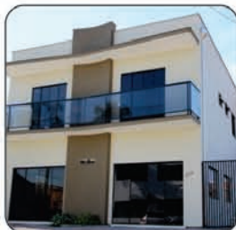
Apto (cod. 0233) Bairro Santa Terezinha Rua Jose Zuchi 02 dormitórios, sala, cozinha, sacada, lavação, banheiro e garagem coberta. Valor: R$880,00
