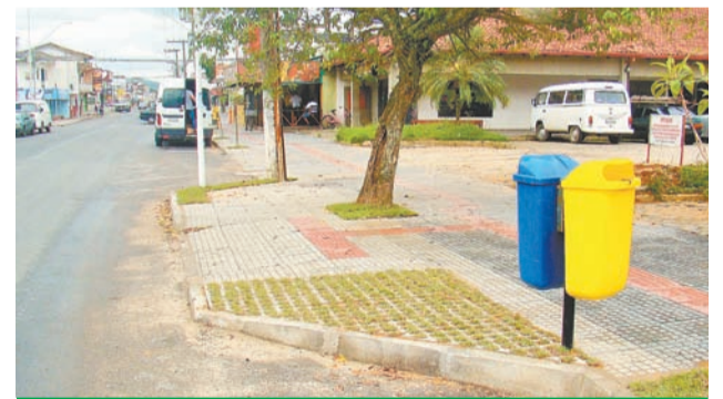
Reurbanização do Binário São Vicente, em Itajaí
