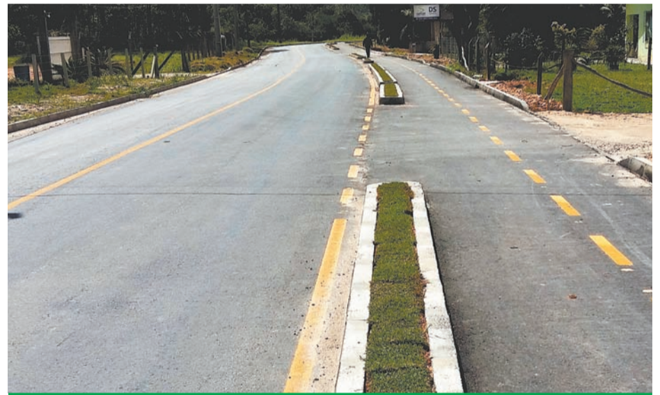
Pavimentação da rua Amadio Beduschi, em Gaspar
