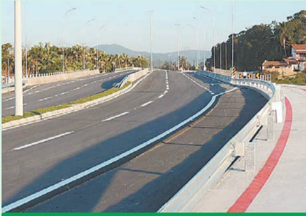
Complexo Viário do Badenfurt, interligando a BR-470 às ruas Bahia e General Osório, em Blumenau
