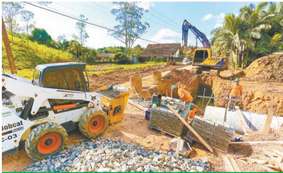
Obras de Infraestrutura na Rua Marechal Floriano Peixoto, em Indaial
