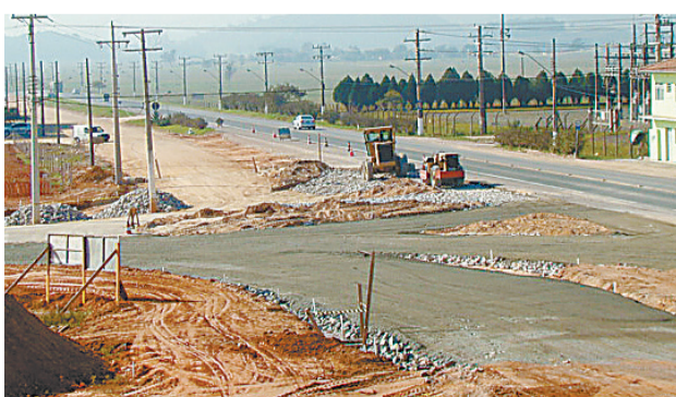
Pavimentação asfáltica de trevo, em Gaspar
