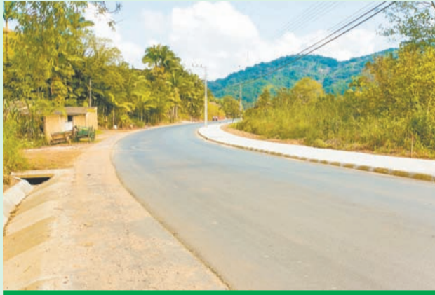
Pavimentação Asfáltica da rua José Patrocínio dos Santos, em Gaspar
