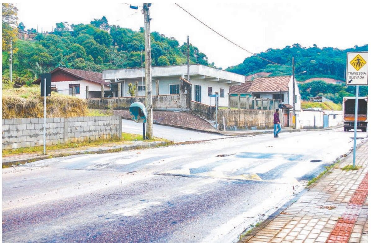
NO bairro Gaspar Mirim, piso tátil existe mas travessia acaba sem ligação com calçada
