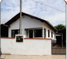
02 Casas e Galpão (cod. 0261)
