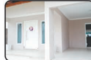
REF. 725 Casa 1 Suite, 2 Dormitórios, 1 BWC, Sala de Visita, Varanda, Cozinha, Área de Serviço, 2 Vaga na Garagem, Churrasqueira, Gás Central, Portão Eletrônico c/ 280m 2 . R$ 480.000,00
