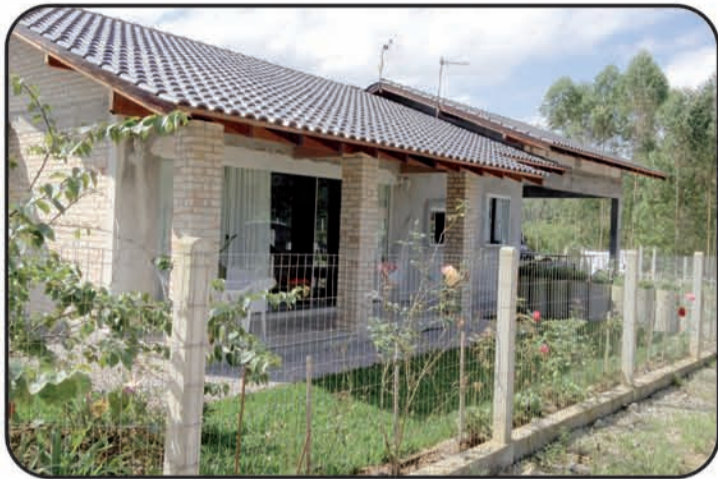
786 - Sito com 1 suite, 2 Dormitórios, 1 BWC, jantar, cozinha, garagem. Totalmente plano, água corrente, poço artesiano. 7 km do Centro, no Alto Gasparinho. - R$ 475.000,00
