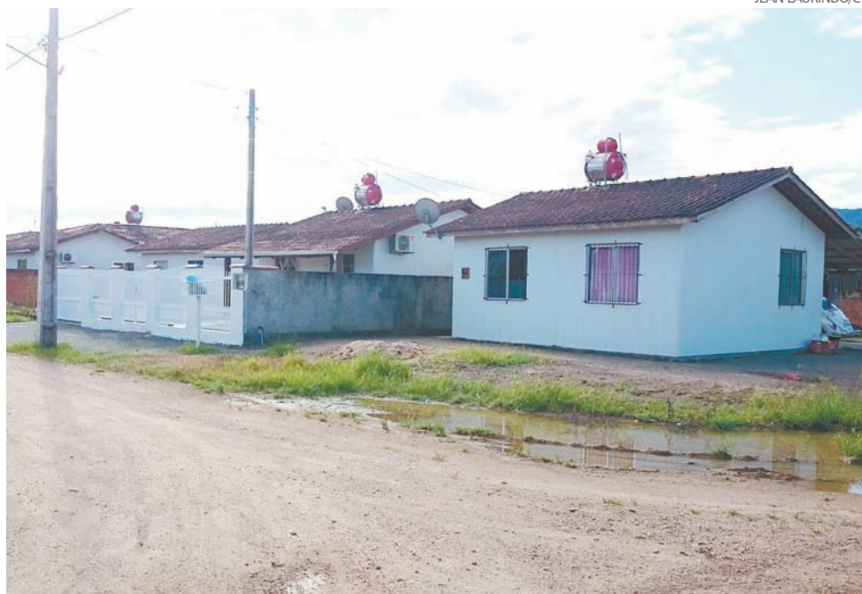
PROBLEMAS em rede de esgoto e rua sem pavimentação prejudicam comunidade
